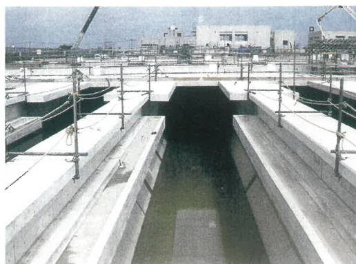
中津終末処理場工事
