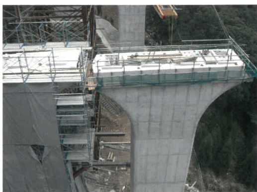
高速道路橋梁下部工工事
