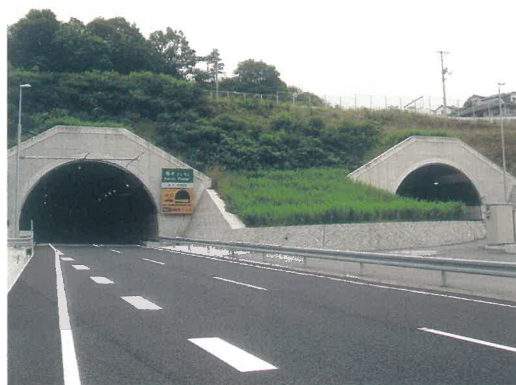
トンネル二次覆工工事
