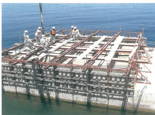
港湾工事・防波堤
